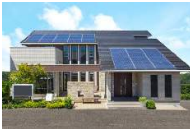
和風建築 (発電機も設置)
